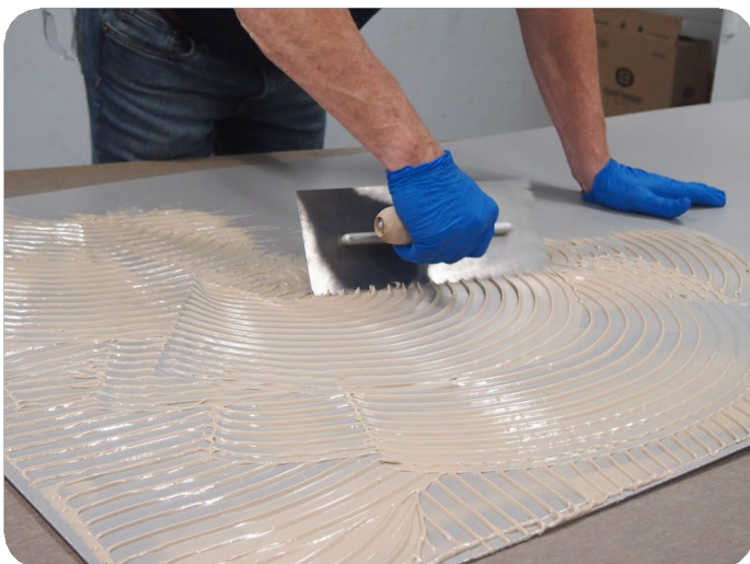
Utiliser la méthode de trait croisé près des bords comme sur l'illustration ci-dessus.
